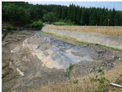
堤体上流側法面（遮水シート）
